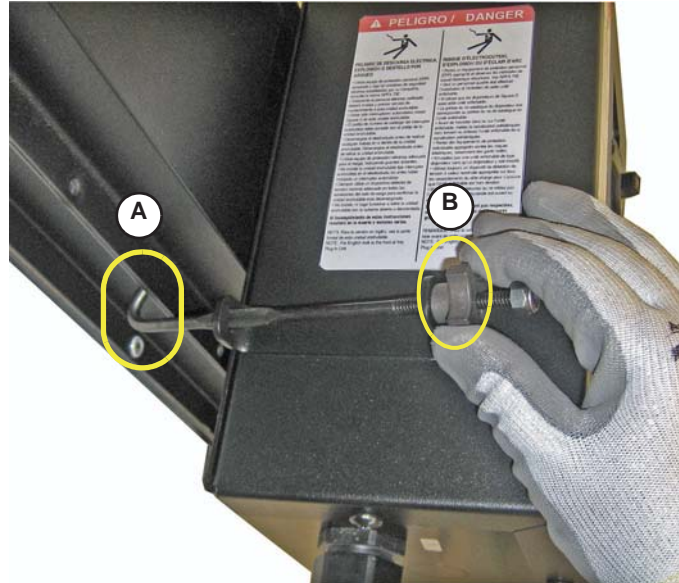
Figure 11 : Fixation de l'unité enfichable sur la canalisation préfabriquée
