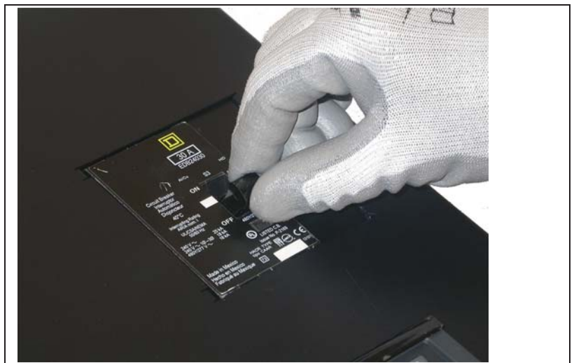
Figure 12 : Mise de l'unité enfichable (de dérivation) en position de marche (I) et d'arrêt (O)
