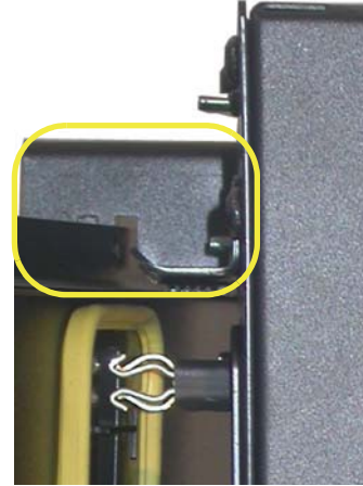
Figura 9: Instalación de la unidad enchufable en el electroducto
