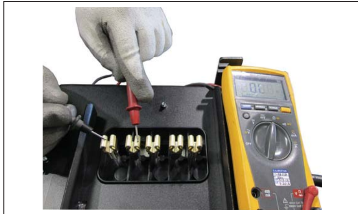
Figure 5 : Essai de résistance d'isolation de l'unité enfichable avant l'installation
