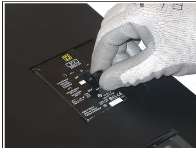
Figura 4: Posiciones de conexión (I) y desconexión (O) de la unidad enchufable (de derivación)
