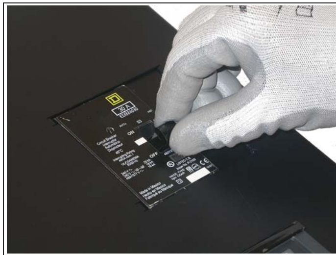
Figure 4 : Mise de l'unité enfichable (de dérivation) en position de marche (I) et d'arrêt (O)
