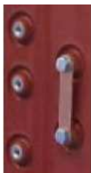
Fot. Przełącznik zacsepów transformatora Trihal – przykład: regulacja 5 pozycyjna.
