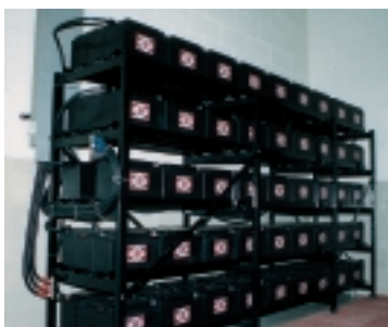
Fig. J14-014: ejemplo de local de baterías.
