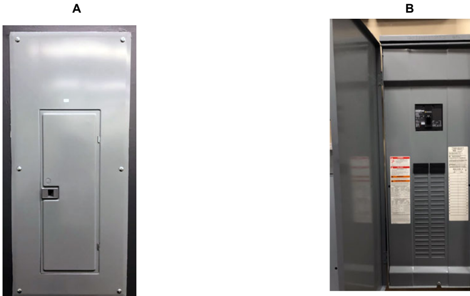
Figura 4 – Centros de carga interiores y exteriores (ejemplos)
