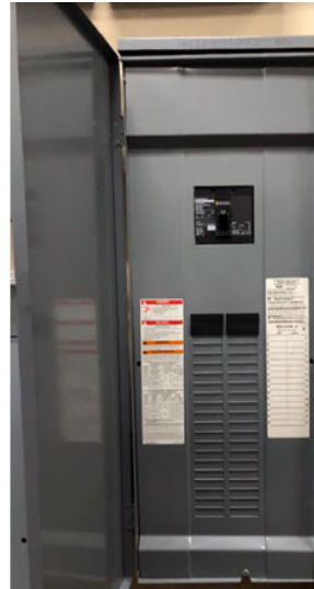
Figure 4 – Centres de charge intérieur et extérieur (exemples)
