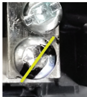
Figure 15 – Appliquer une marque après avoir serré la vis de la barre de neutre inférieure droite
