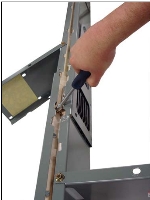
Figura 3: Instalación de los tornillos de conexión a tierra
