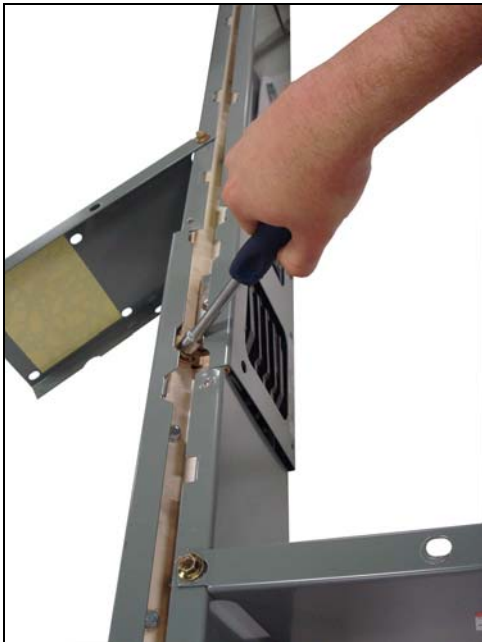
Figure 3 : Installation des vis de raccordement à la terre
