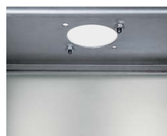
Detail der Verstärkungsplatte.
