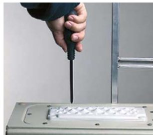
Bohren Sie ein kleines Loch in die Membran.
