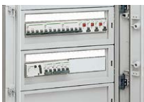
Ausschnitt aus dem Stromkreismarkierungssystem.
