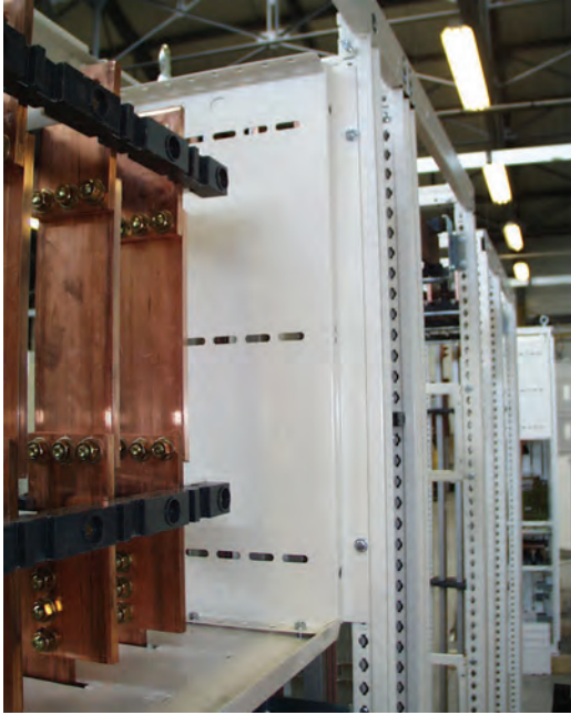
Ontkoppelbare verticale barenstellen.
