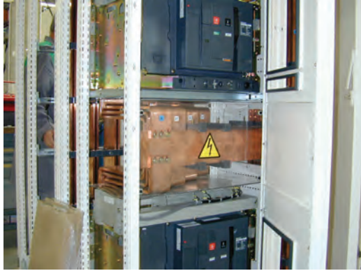
Het bronomschakelingsysteem in dezelfde cel.
