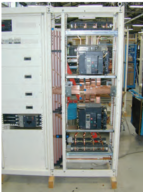
Système de changement de source dans 2 armoires combinées.
