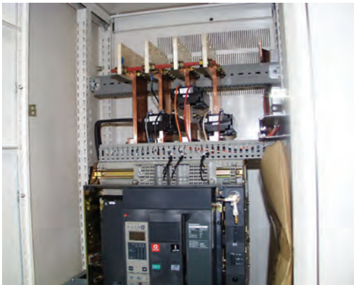
CT sur jeux de barres verticaux.
