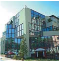
Heizungs- und Lüftungssteuerung in Gebäuden
