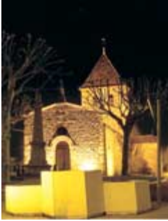
Beleuchtung von öffentlichen Gebäuden
