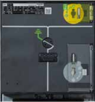
Visibilité des contacts principaux
