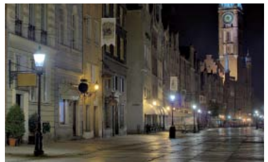
Eclairage public à LEDs
