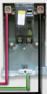
Sectionneur pour climatiseur
