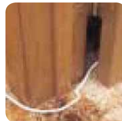
Cordon d'alimentation coincé dans le jambage de la porte
