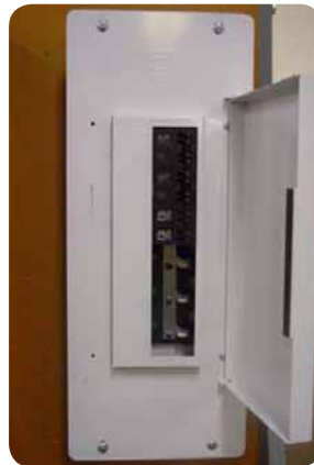
Étape 3 Installez le nouveau HFLCI
