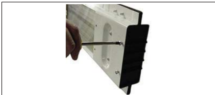
Figure 14 : Serrage des vis autoformeuses d'extrémité Plastite ®
