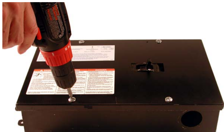
Figura 5: Sujeción de la cubierta de la unidad enchufable
