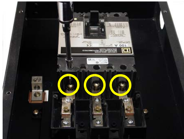
Figure 25 : Installation des trois courtes vis de borne du côté ligne.
