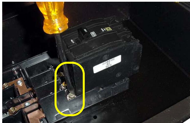
Figura 40: Desmontaje del interruptor automático QOB
