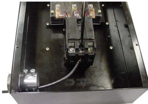
Figure 16 : Câblage d'une boîte de jonction
