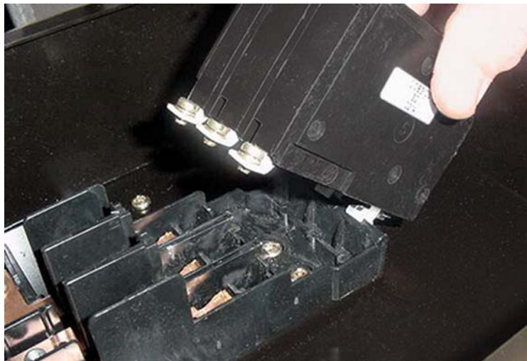
Figure 41 : Retrait du disjoncteur QO/QOB
