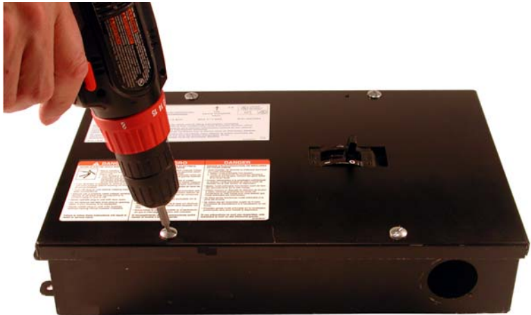
Figura 38: Desmontaje de la cubierta del gabinete
