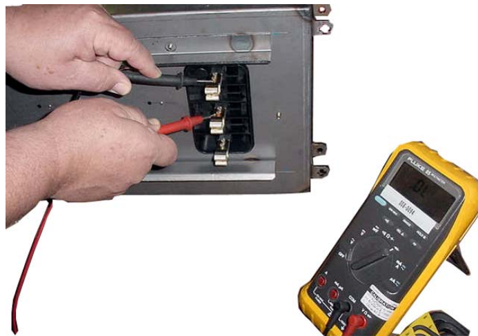
Figura 7: Prueba de aislamiento de la unidad enchufable antes de la instalación
