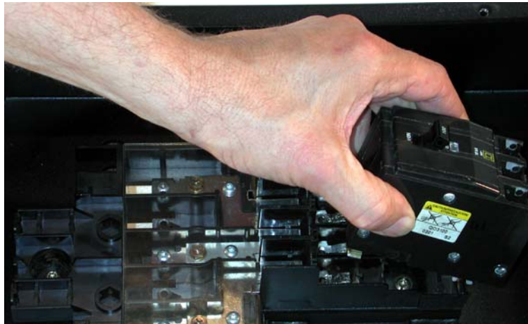
Figura 28: Instalación del interruptor automático QO
