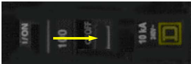
Figure 37 : Mise hors tension (O/OFF) du disjoncteur
