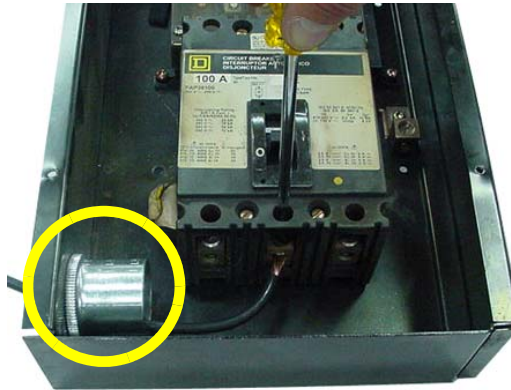
Figure 14 : Câblage du côté charge (FA)
