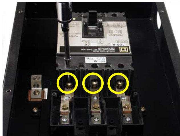
Figura 25: Instalación de los tres tornillos de terminal cortos para el lado de línea
