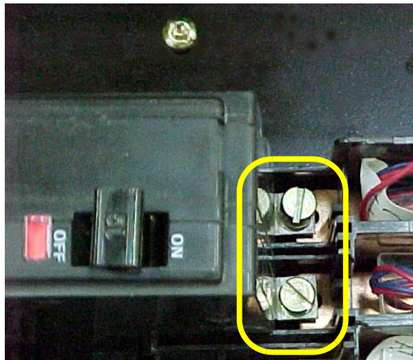
Figure 31 : Raccordement du QOB—Côté ligne
