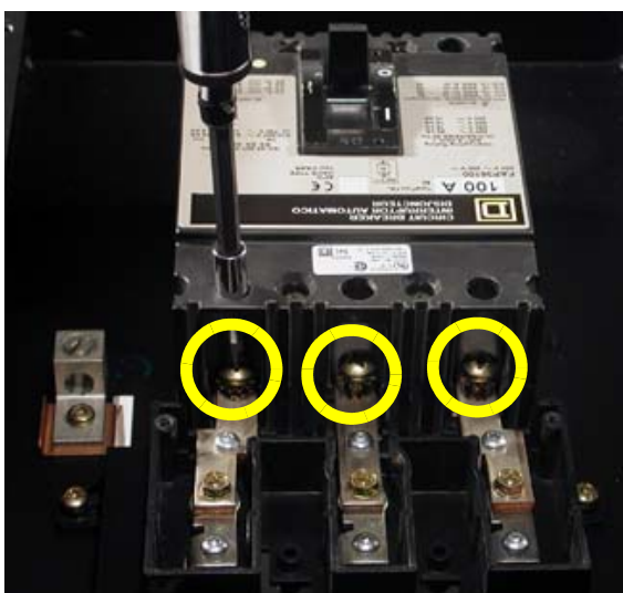
Figura 34: Extracción de los tres tornillos de terminal cortos del lado de línea
