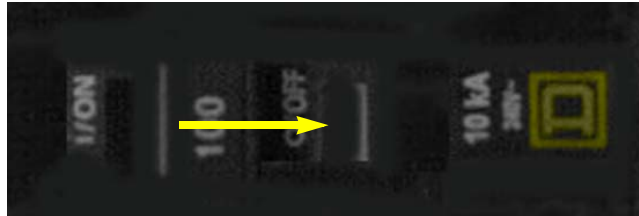
Figura 37: Desconexión (O/OFF) del interruptor automático
