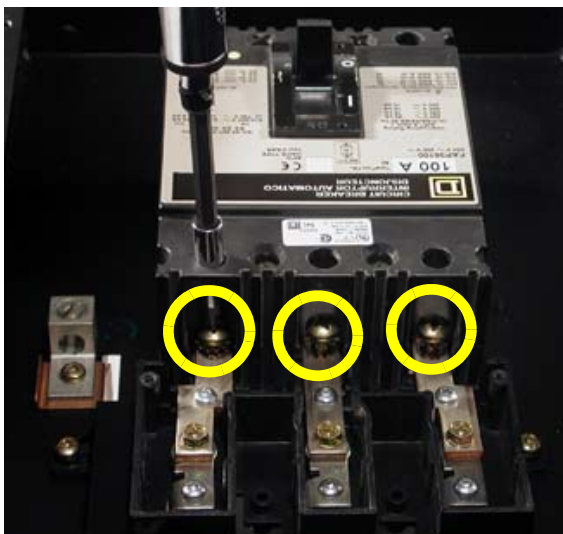
Figure 34 : Retrait des trois courtes vis de borne du côté ligne
