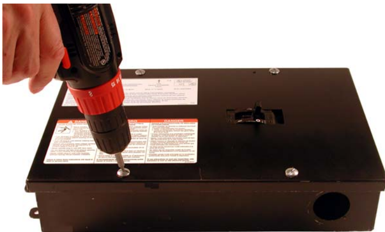
Figure 38 : Retrait du couvercle du coffret
