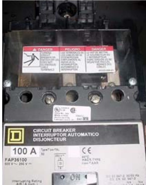
Figura 4: Colocación de la etiqueta de alimentación inversa (interruptor automático)
