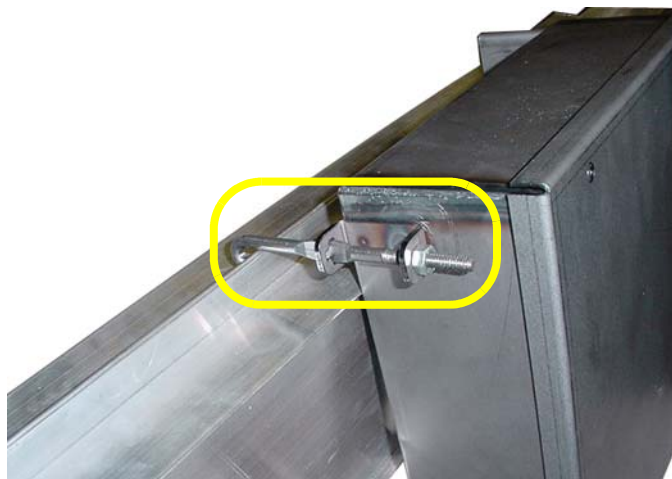
Figure 13 : Fixation de l'unité enfichable sur la canalisation préfabriquée
