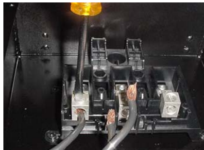
Figure 16 : Câblage d'une boîte de jonction
