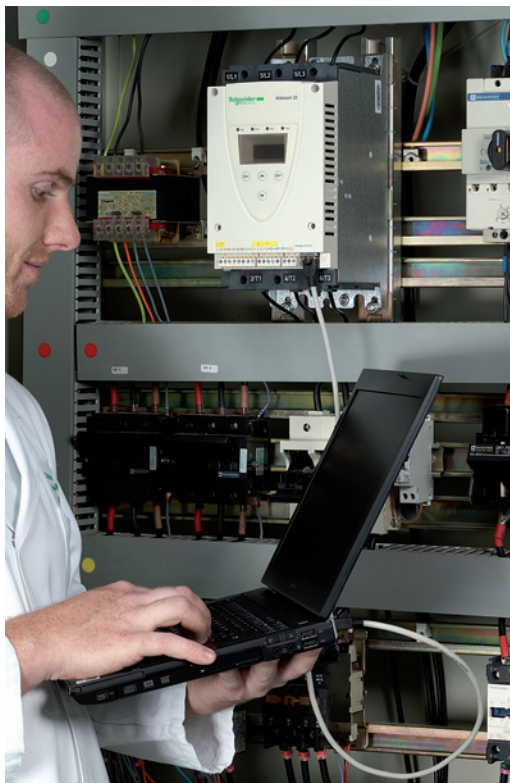
Mise en service du démarreur-ralentisseur ATS 22 avec le logiciel SoMove lite
