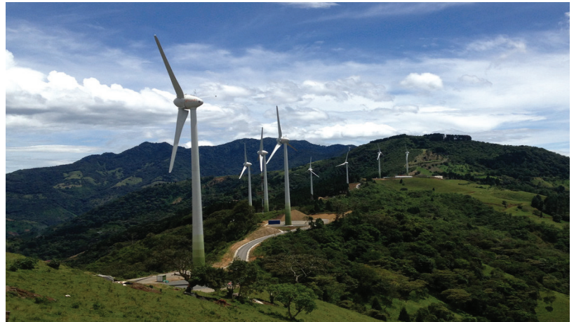
Parque Eólico Valle Central
