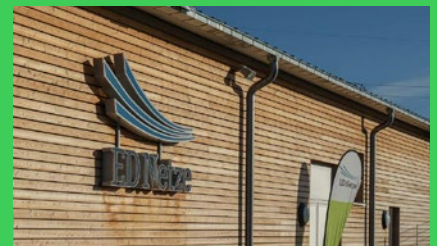
ED Netze baut ein SF 6 -freies Umspannwerk für die Welt von morgen
