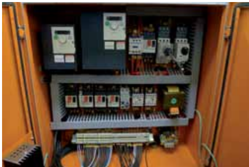
Mehrere Antriebe können ohne Zwischenraum nebeneinander montiert werden, um Platz zu sparen.
