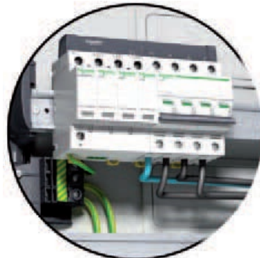
Überspannungsableiter iPRD 3P+N + iC60N 3P+N
