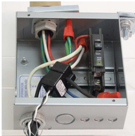
Figure 2. TC connecté au circuit pour installation de type boîte de dérivation de canalisation
