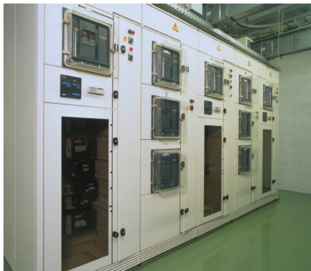
Masterbloc uitgerust met Masterpact en Compact NS
