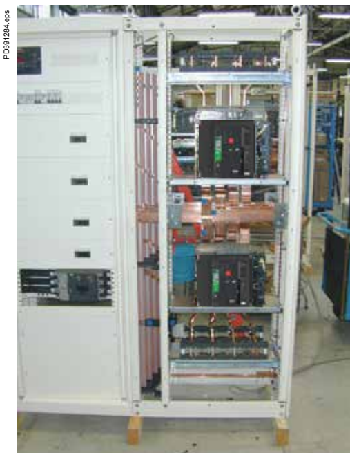
Sistema de inversor de rede em 2 celas combinadas.
