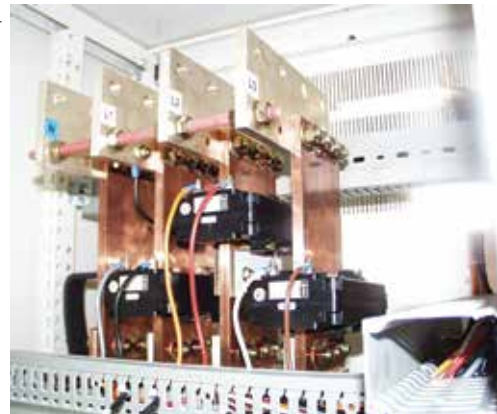
Espaçadores entre os barramentos.
