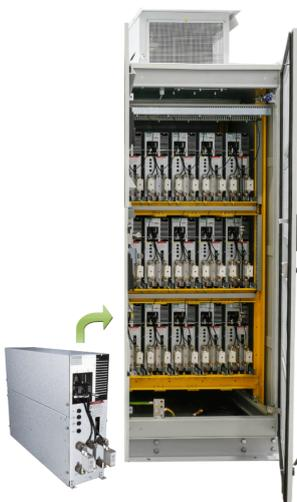
Abb Leistungszellen-Schaltschrank und Leistungszellen
