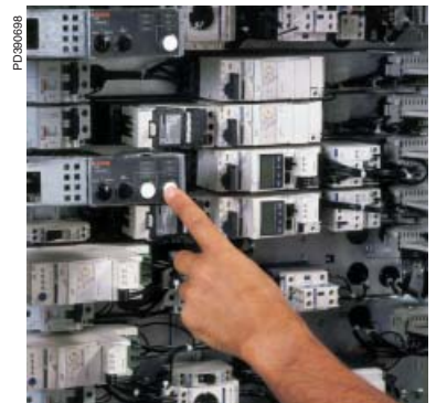
Működtetés a helyi vezérlő- és kijelzőegységgel (LCDD-vel).
