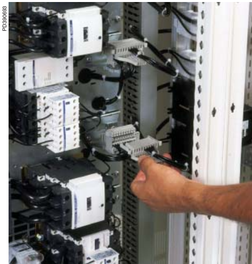
Kiegészítő csatlakozóblokk a kihúzható szerelőlapra szerelve.
