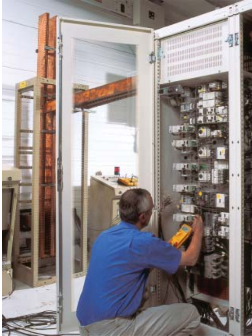
Feszültségmérés a mágneskapcsoló tápcsatlakozóján.
