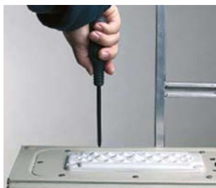
Realizzare un piccolo foro nella membrana.
