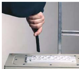
Inserire il cavo o il tubo nel foro di guida.
