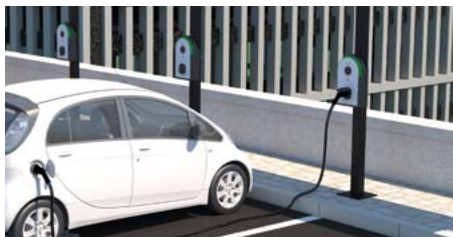
Avec trottoir en béton
