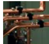
Conjunto de sensores Easergy TH110 fijos en las 3 fases de una conexión eléctrica
