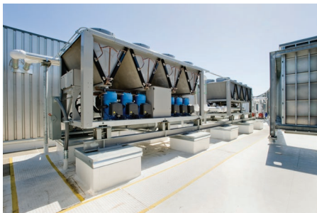
Groupe de production d'eau glacée (à condensation par air)
