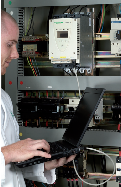
Mise en service du démarreur-ralentisseur ATS 22 avec le logiciel SoMove
