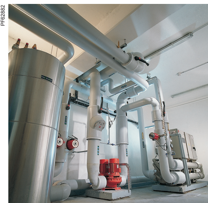
Application de pompage
