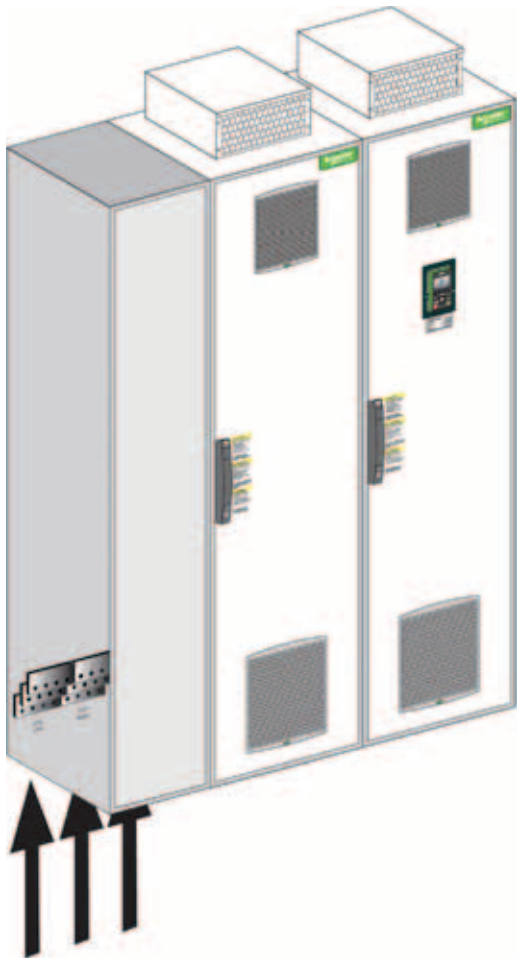
Dulapurile adiționale permit cablarea pe jos
