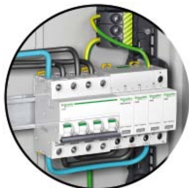
Surge arrester iPRD 3P+N + iC60N 3P+N
