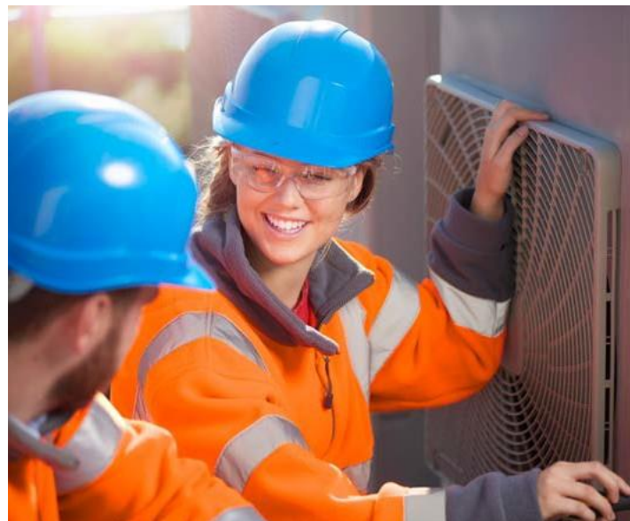
Без надлежащего обслуживания потребление энергии инфраструктурой электроснабжения, ОВКВ и освещения может сильно возрасти – рост составит от 10 до 20 % по мере постепенного сбоя системных настроек.
