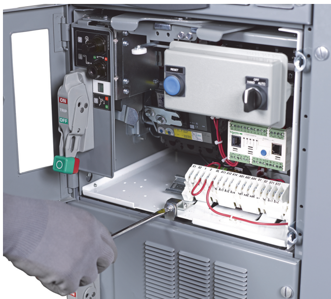
Figura 9: Fijación del panel de bloqueo de la unidad de control
