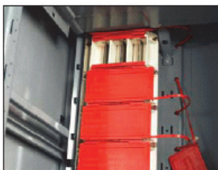
Figura 7: Desmontaje de la persiana manual de la barra
