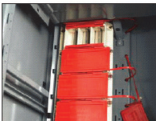
Figure 7 : Retrait de volet manuel des barres-bus
