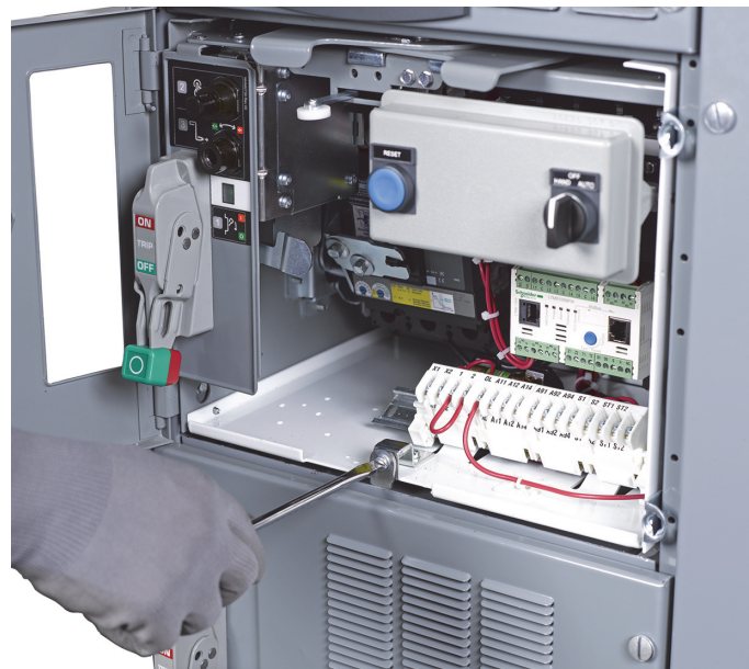
Figure 9 : Serrage du loquet de blocage de l'unité de contrôle
