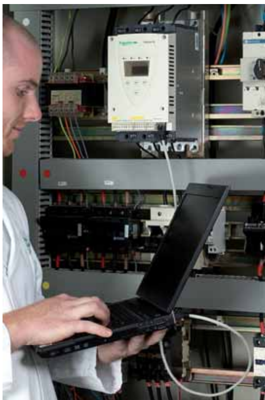
Puesta en marcha del arrancador progresivo ATS 22 con el software de configuración SoMove lite.
