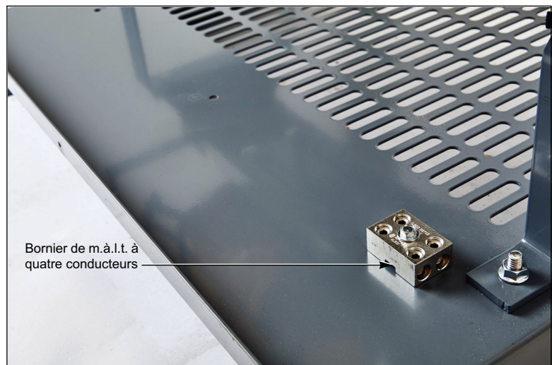
Figure 24 : Bornier de m.à.l.t. à quatre conducteurs
