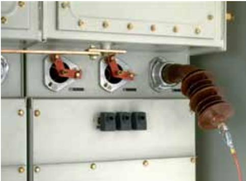
Hochspannungs-Kabelprüfung (1-phasig) über rückseitig montierten Prufadapter
