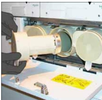
J Extraire le bouchon et le poser verticalement sur une surface stable et propre.
