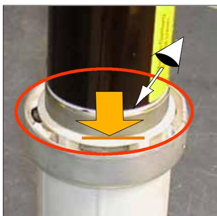
J Emboîter le fusible dans les pinces jusqu'en butée contre la bague d'appui.
