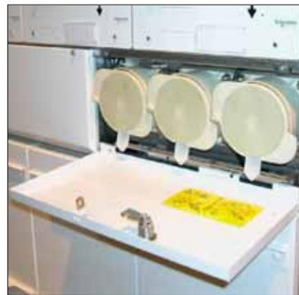
J Les bouchons des puits-fusibles sont maintenant accessibles.
