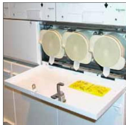
J Ouvrir complètement le capot pour accéder aux bouchons des puits-fusibles étanches.
