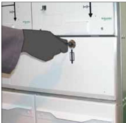
J Déverrouiller le compartiment des fusibles avec la clé correspondante.
