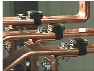
Kuva 1.8. Easergy TH110 -antureiden ryhmä, jotka asennettu vaihekohtaisesti
