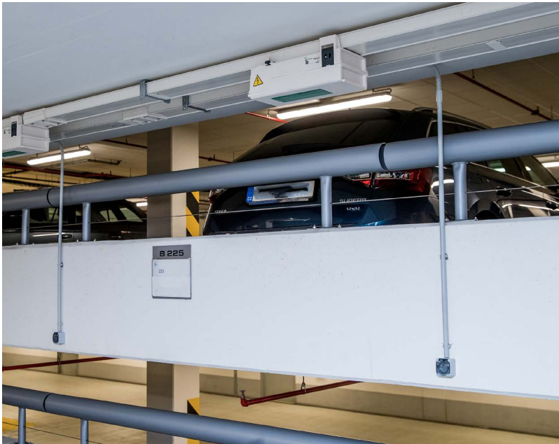
Odbočovací jednotka přípojnicového vedení Canalis napájející domovní zásuvku 2 kW - kdykoli možná rychlá záměna za nabíjecí stanici a odpovídající jištění
