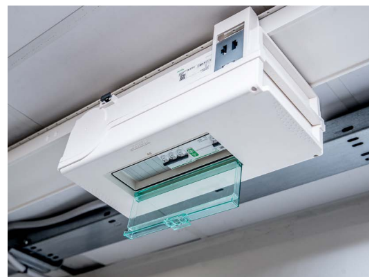
Odbočovací jednotka přípojnicového vedení Canalis vybavená jističem a proudovým chráničem pro připojenou nabíjecí stanici
