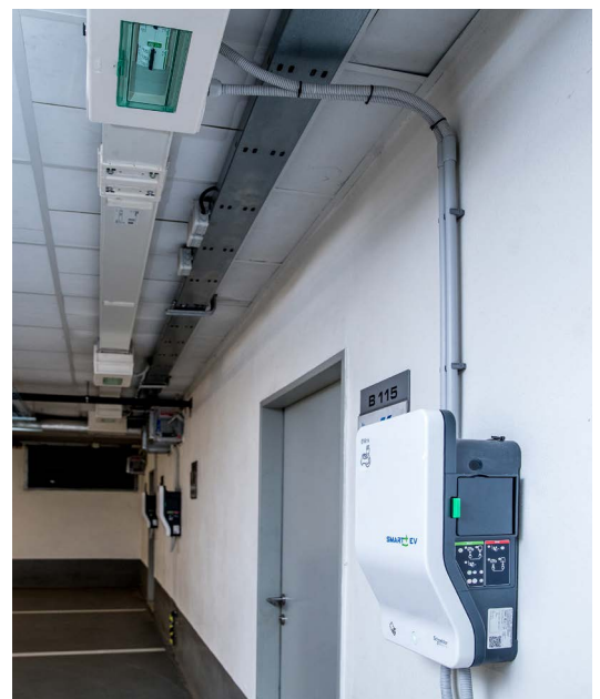
Odbočovací jednotka přípojnicového vedení Canalis k nabíjecí stanici Smart WallBox 22 kW
