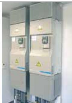
de 1000 A à 4000 A, avec un degré de protection IP 55.
