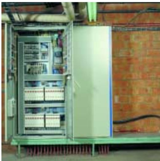
*L'utilisation de la technologie QuickFit a permis de réduire sensiblement la taille de l'armoire.*
