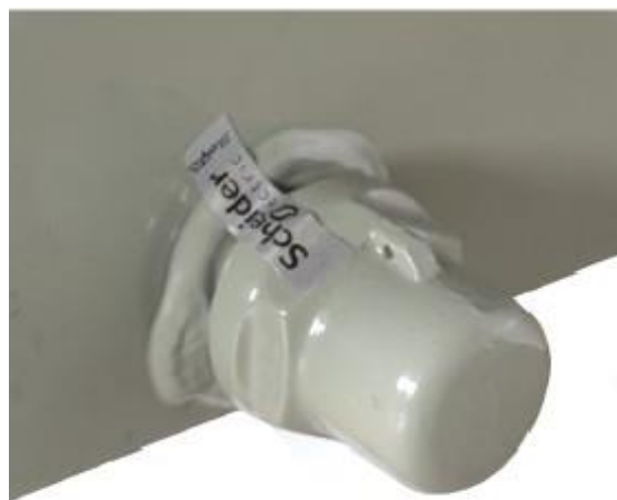
Obr. 12: Vypouštěcí ventil
