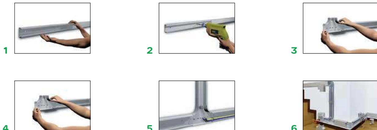
1. Primeiramente, corte as canaletas nos diferentes comprimentos que você precisará para a instalação. Posicione a base da canaleta na parede a pelo menos 40 cm do piso. A fita adesiva dupla face pode servir de guia nesta etapa.
