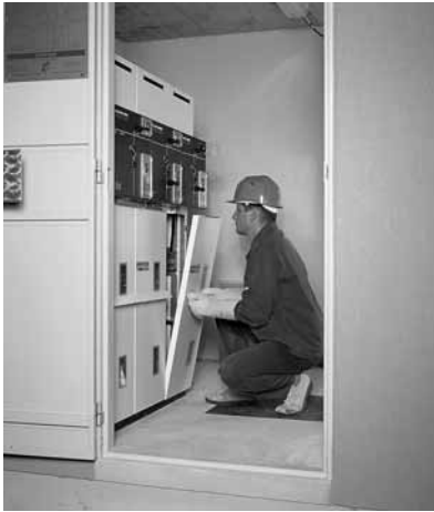
Fig. B34: Centro de transformación en prefabricado con maniobra interior.
