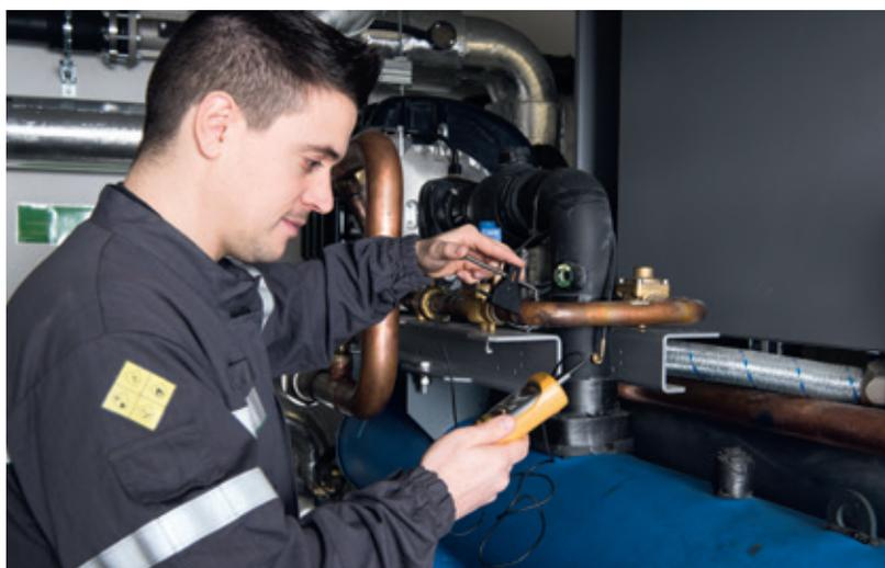
La prestation Schneider Electric permet de détecter toute anomalie sans nécessiter d'opération intrusive sur l'installation : les échantillons d'huile peuvent être prélevés sur des équipements en fonctionnement.
