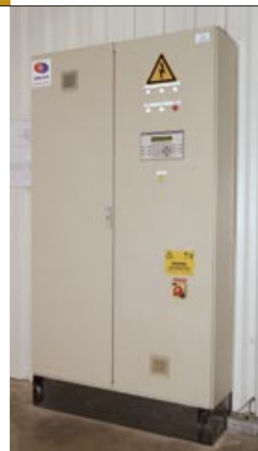
Standaard uitrusting frequentiesturingen in IP54 kast gestuurd via PLC en dialoog via XBT
