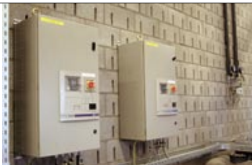
Standaard uitrusting frequentiesturingen in IP54 kast gestuurd via PLC en dialoog via XBT
