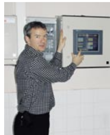
Dhr. Alain Thijs, technisch directeur Dapesco, laat zien hoe je met Magelis makkelijk de gehele installatie kan bedienen
