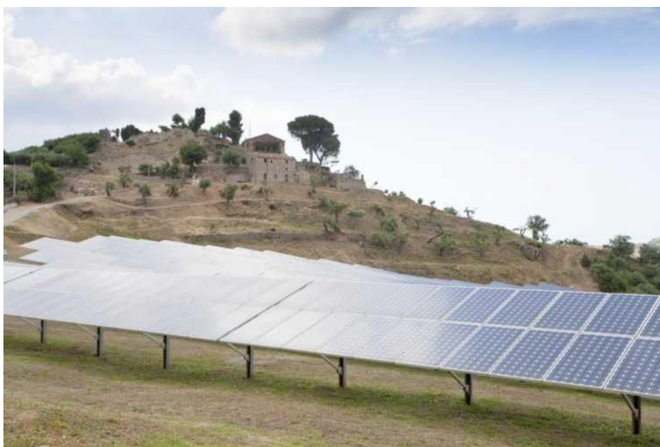
图 3 汤加群岛乡村电气化项目
