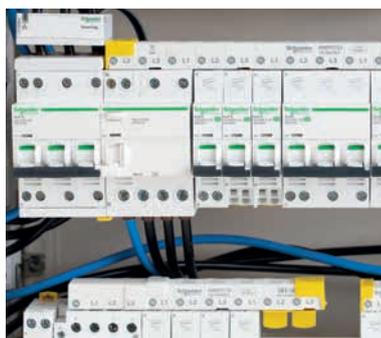
Une gamme complète de peignes horizontaux permet l'installation optimisée de tous les appareils, quelle que soit la configuration (1P+N, 3P, 3P+N, interrupteurs différentiels et disjoncteurs différentiels en tête de groupe, avec ou sans auxiliaire). Les peignes sont sécables et réutilisables.
